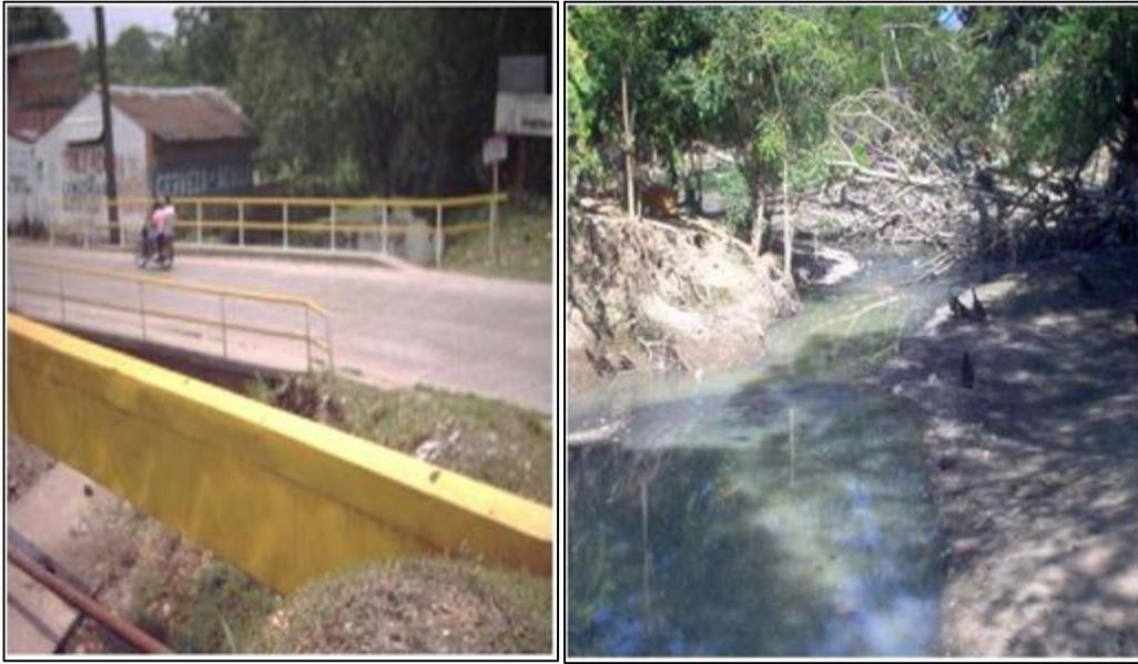
Foto 9. Problemas de empozamientos cerca de carrera 2<sup>da</sup> - sobre Box Coulvert - Caño.
